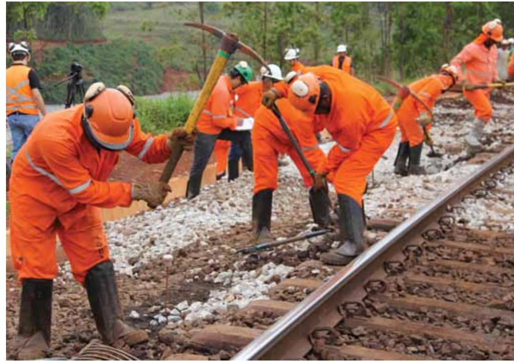
Remoção do lastro
