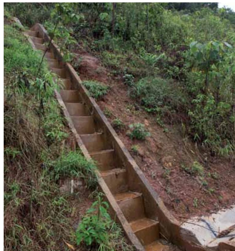
Obra permite o escoamento de água da chuva evitando erosões no solo
